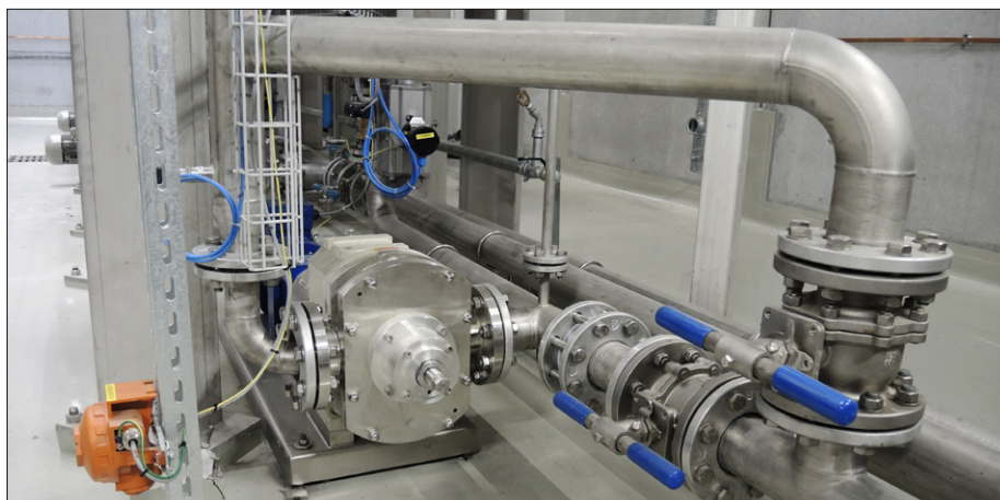
Bild 2: Edelstahlverrohrung.
